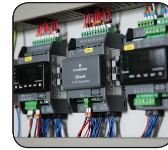
CE Standartlarında Güç ve Kontrol Panosu Power and Control Panel with CE 2006/95/EC Standards
